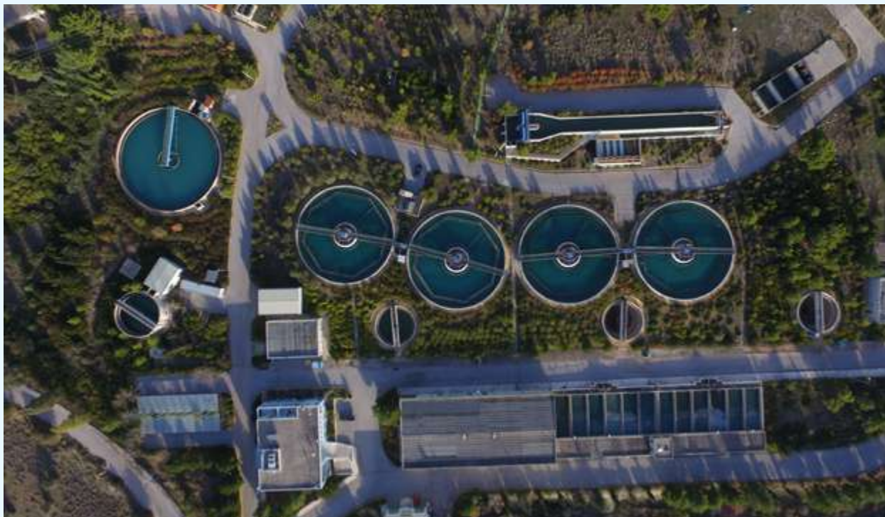
Μονάδα Επεξεργασίας Νερού Ασπροπύργου, Πηγή: Αρχείο ΕΥΔΑΠ
