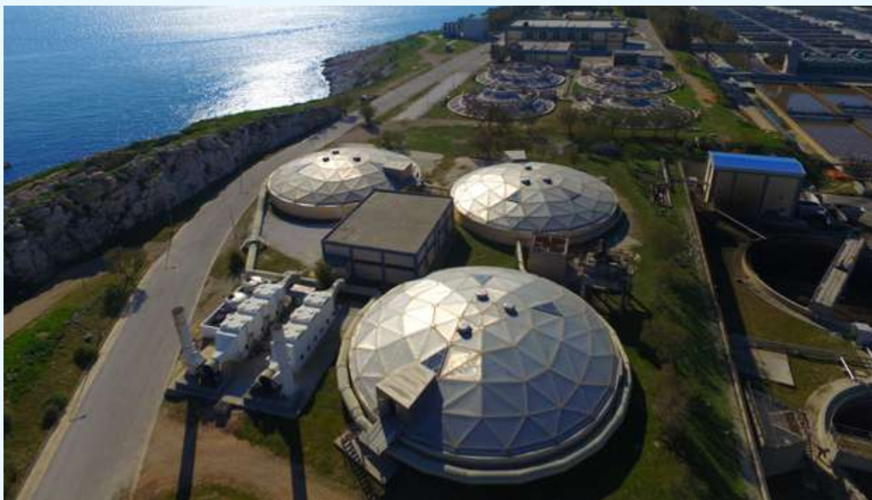
Κέντρο Επεξεργασίας Λυμάτων Ψυττάλειας, Πηγή: Αρχείο ΕΥΔΑΠ
