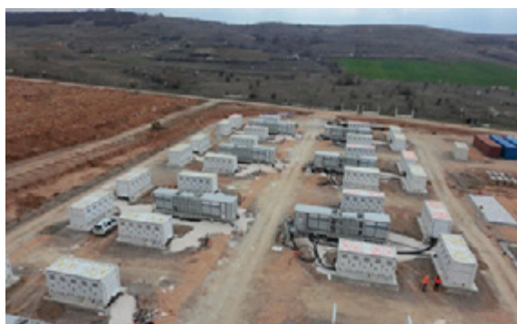
Συστοιχία συσσωρευτών του Σταθμού Ηλεκτροχημικής Αποθήκευσης Μελίτης Ι.
