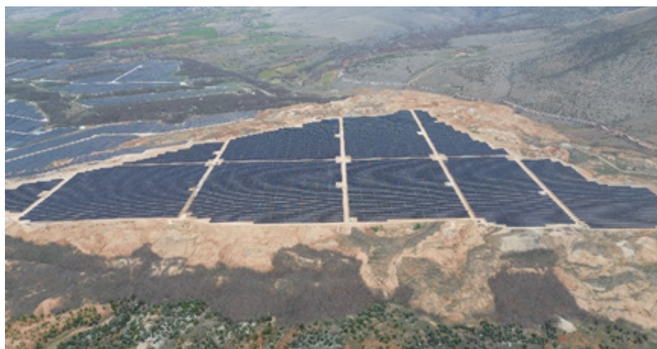
Τμήμα φωτοβολταϊκού σταθμού ισχύος 171 MW σε περιοχή αποθέσεων του Λιγνιτικού Κέντρου Δυτικής Μακεδονίας.
