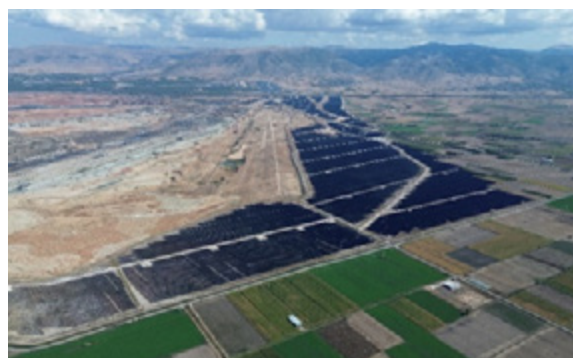
Τμήμα φωτοβολταϊκού σταθμού ισχύος 550 MW πλησίον του ΑΗΣ Αγίου Δημητρίου
