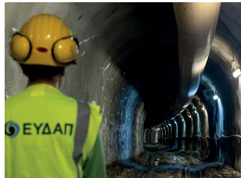
Εργασίες Κατασκευής Σήραγγας του Κέντρου Επεξεργασίας Λυμάτων Ραφήνας - Πικερμίου - Σπάτων - Αρτέμιδας, Πηγή: Αρχείο ΕΥΔΑΠ ▲
