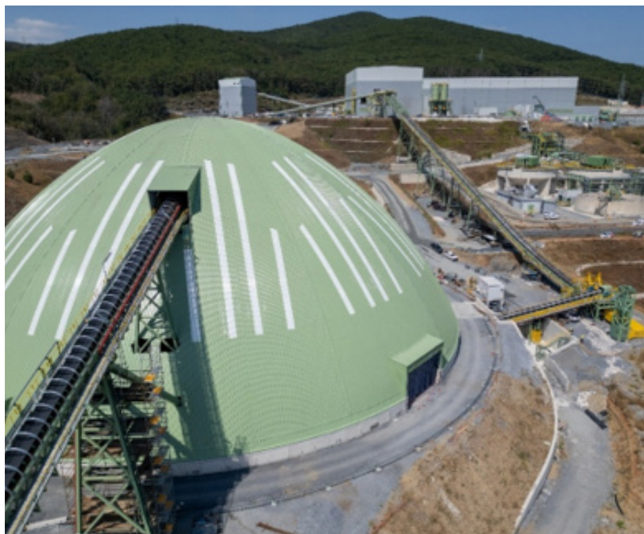
Σκουριές. Θόλος στέγασης προθραυσμένου μεταλλεύματος και στο βάθος το εργοστάσιο επεξεργασίας μεταλλεύματος
